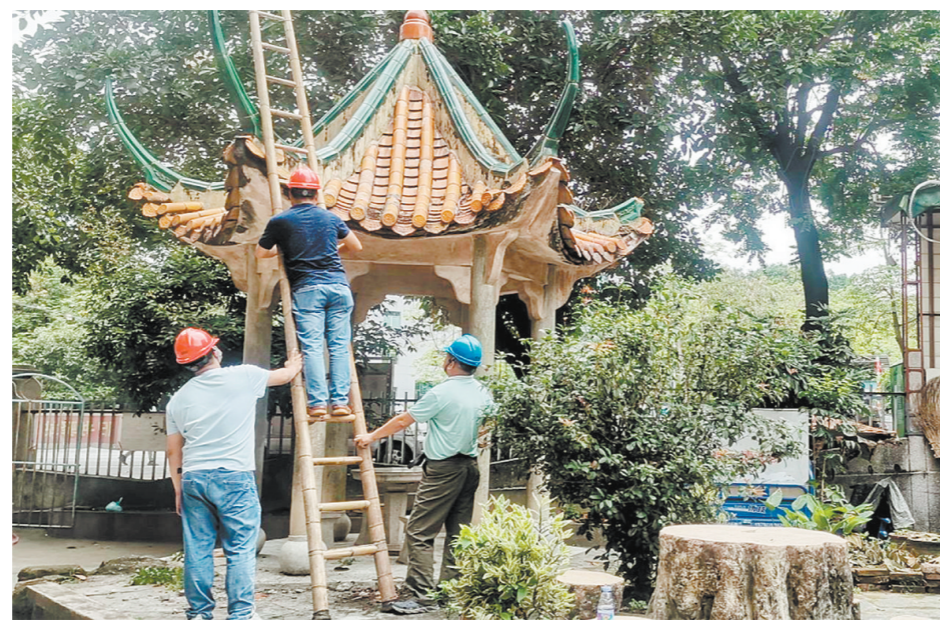
社区“大党委”组织施工队采取“原地修缮”方式,加固凉亭。
