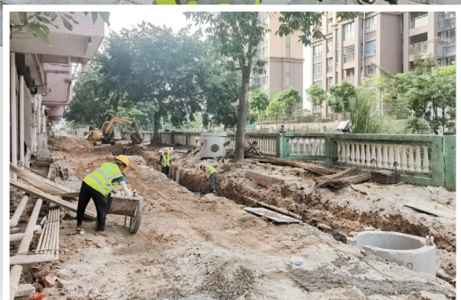
▲今古洲新世纪花园改造现场,施工工人正在作业。
