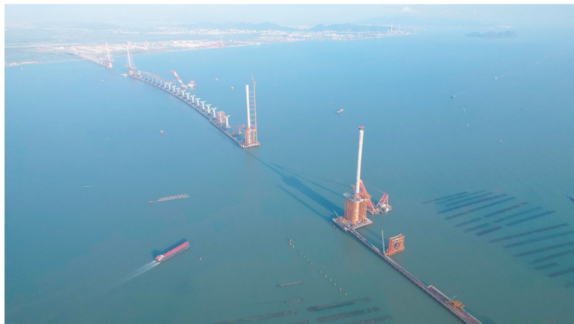
黄茅海跨海通道项目整体建设进度已超7成,距离实现2024年底建成通车目标越来越接近。 陈俊锋 摄
