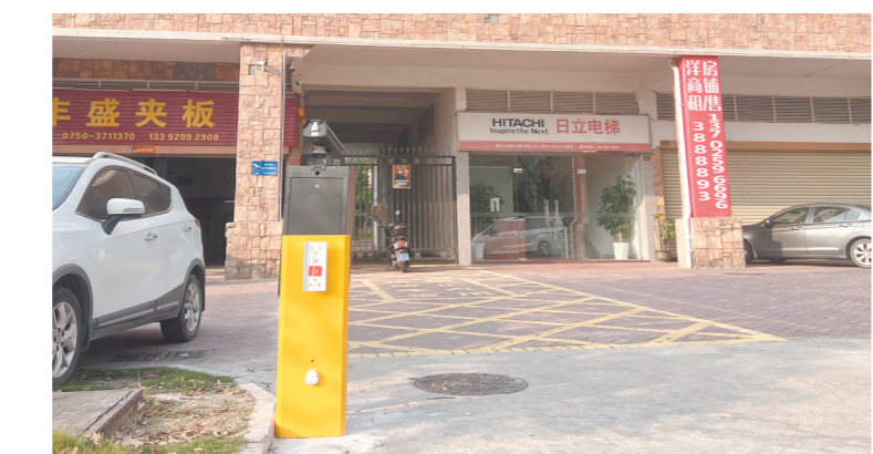
路口处已安装车牌识别设备。
