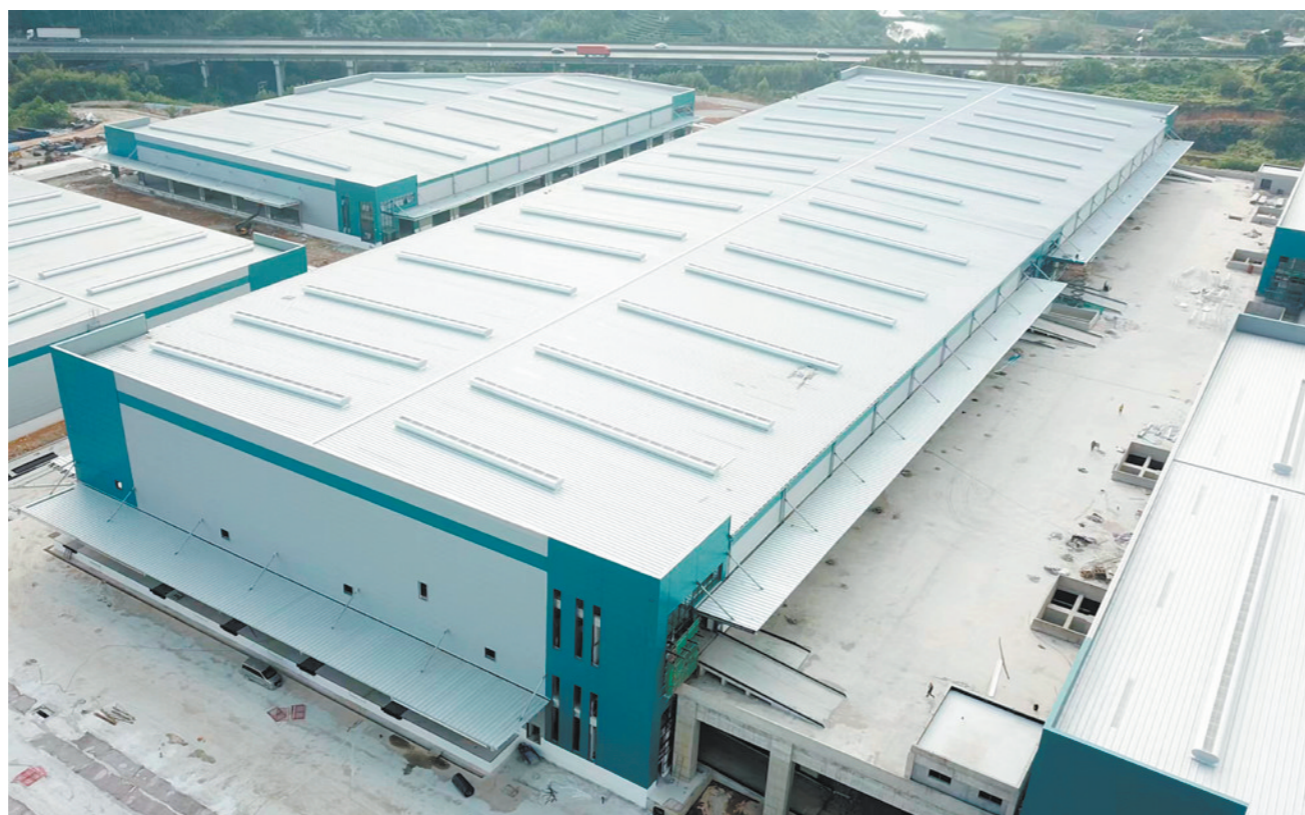
走进宝鹤物流项目工地,一座座现代化的高标准物流仓储建设进展喜人。
