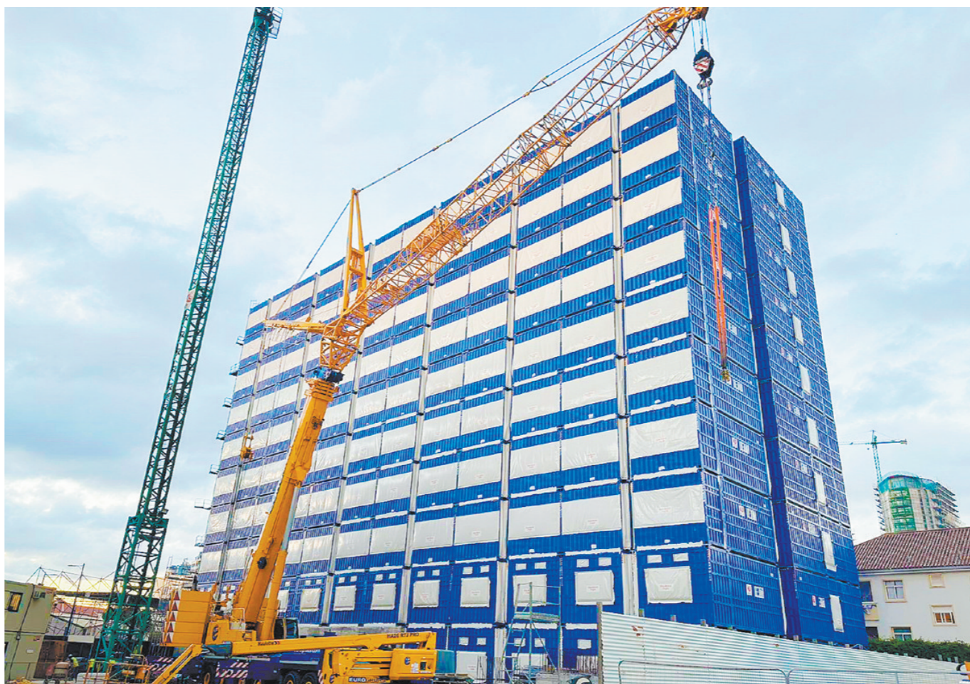
建设中的直布罗陀高端养老公寓。
