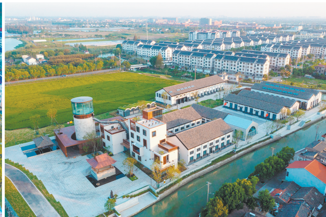
姚庄镇丁栅沉香共同富裕聚落是长三角一体化示范区城乡有机更新的样板工程。
