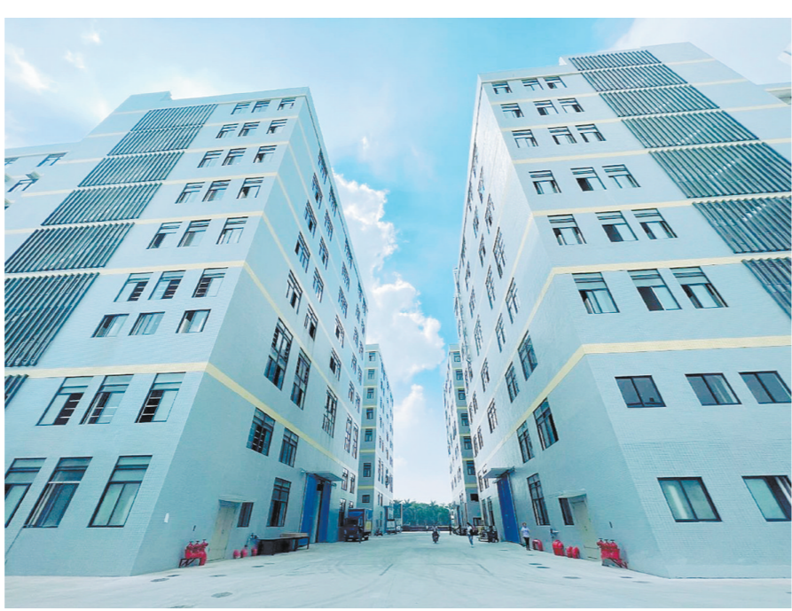
创美科技园“工改工”一期项目是鹤山工业城(共和镇)首个工业用地升级改造项目。
