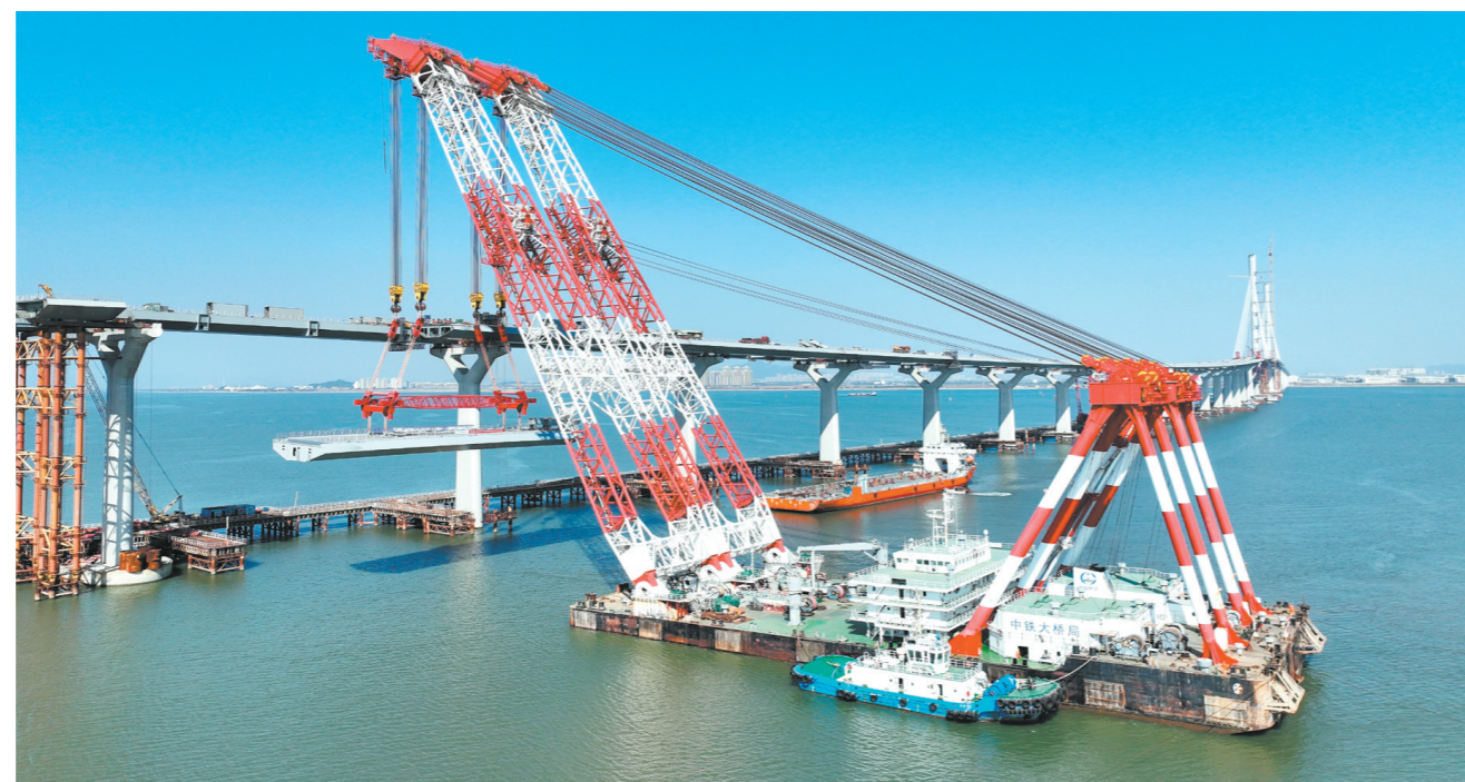
昨日,黄茅海跨海通道中引桥顺利合龙。图为建设者在钢箱梁架设作业。
