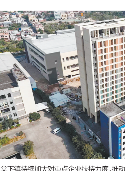
棠下镇持续加大对重点企业扶持力度,推动企业做大做强。图为利华集团新建片区。
