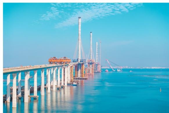
随着全线节段梁架设任务圆满完成,黄茅海跨海通道进入钢箱梁架设冲刺阶段。图为西引桥节段梁架设现场。
