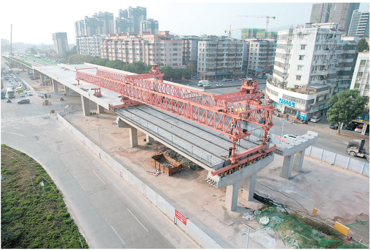
三和大道跨线桥梁架。
