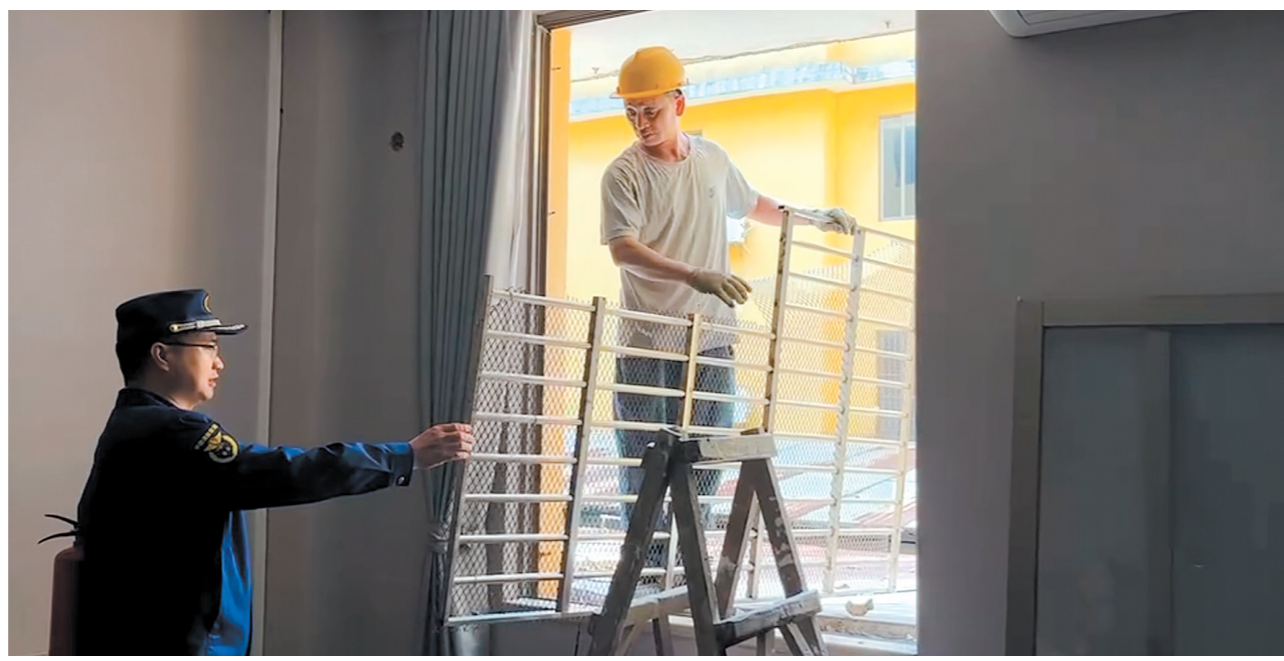
检查人员协助机构工作人员现场将防盗网拆除。
