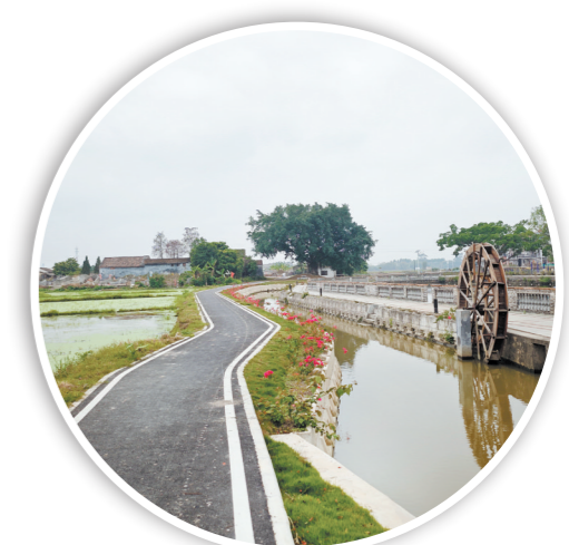
三门里节点项目主要对村庄水塘、排水渠等房前屋后农村水系进行综合治理及周边环境提升,预计5月底前全面完成。
