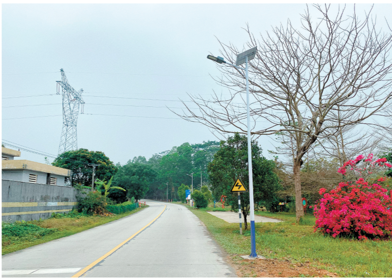
130多盏太阳能路灯全部安装完毕并投入使用,有效提升镇村照明品质。
