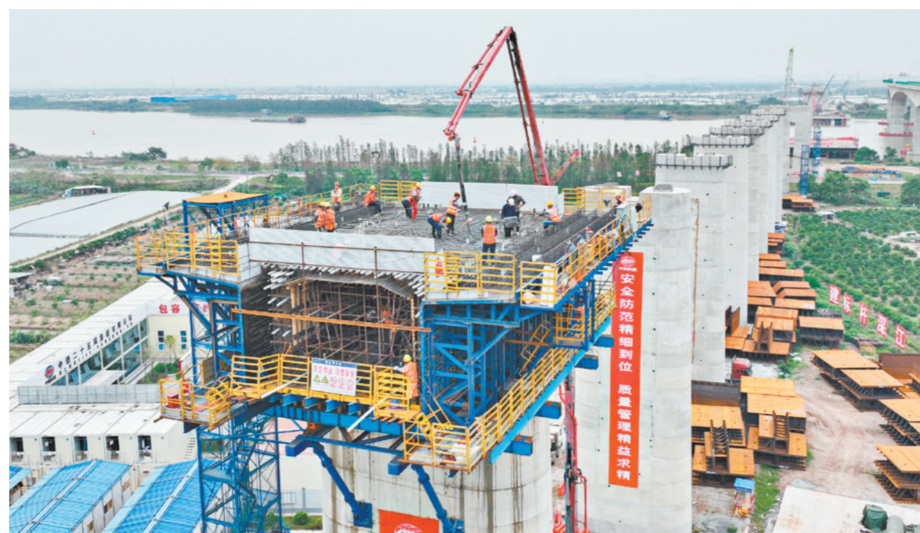
深江铁路江门段首个连续梁开始浇筑。
