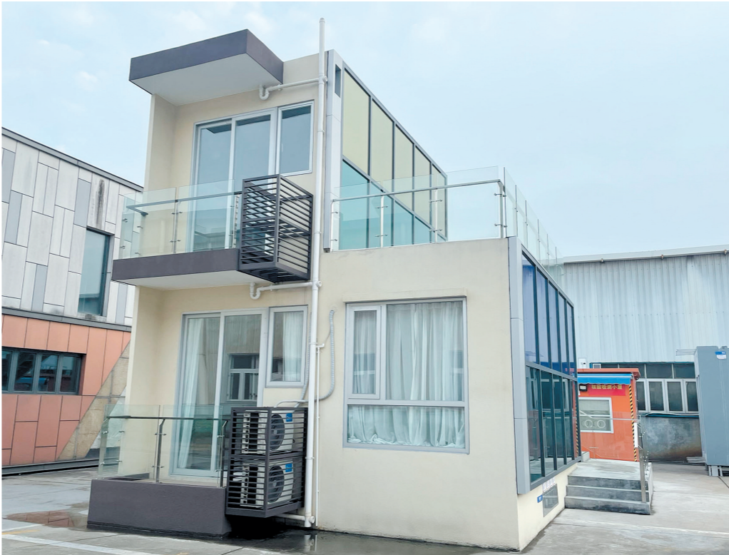
中集模块化建筑通过模块化建筑+光伏太阳能板,让建筑变身大型“充电宝”。
