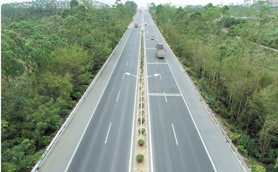
国道G325线恩平至大槐段路面改造工程有效提升道路质量和群众出行体验。
