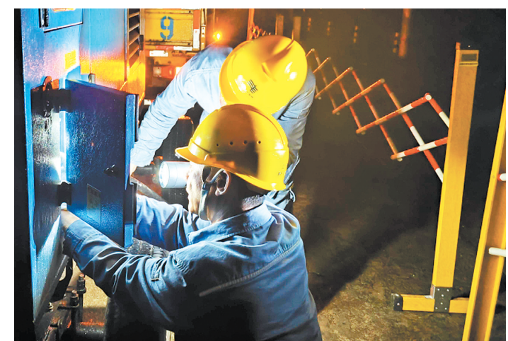
供电部门迅速采取措施,保障村民供电。
