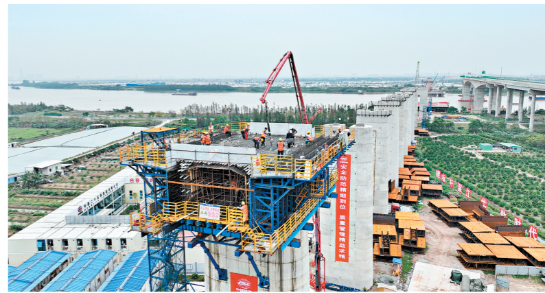
深南高铁江门至深圳段,将与正在建设的深江铁路共线。
