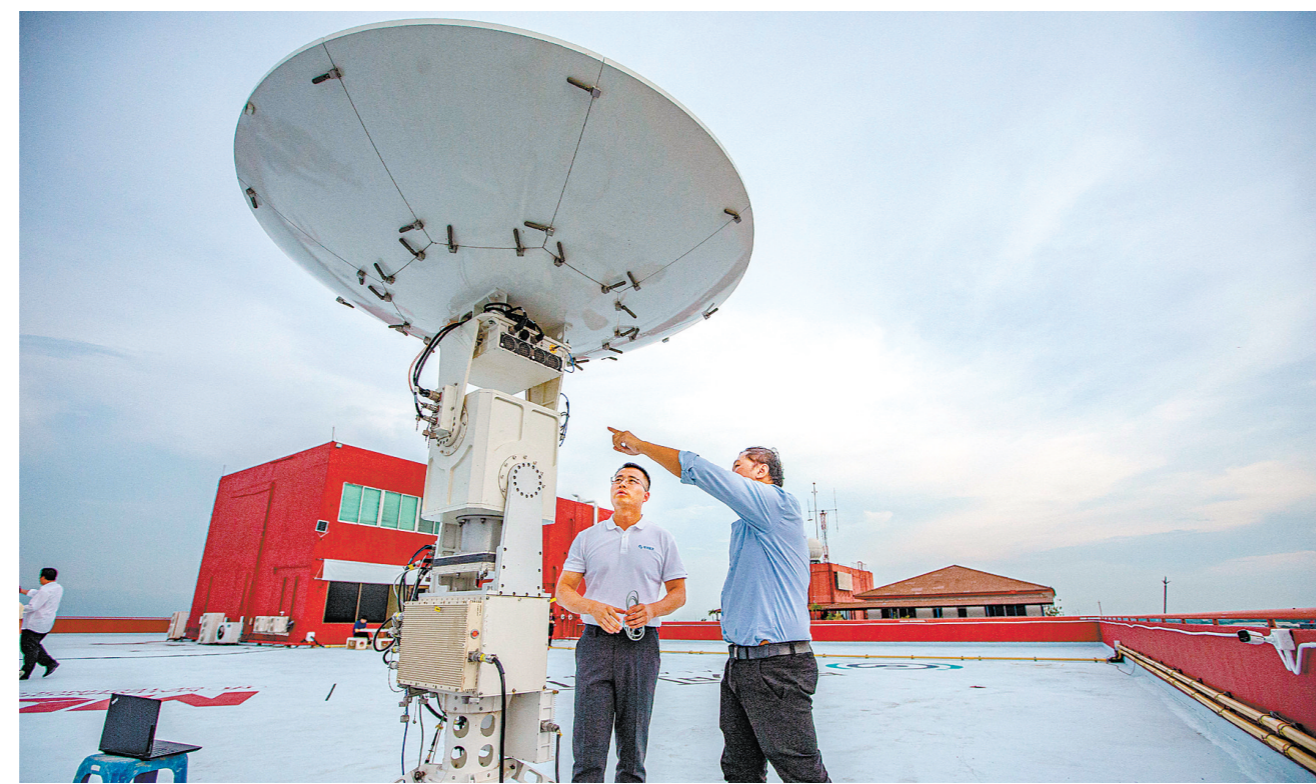
5月17日,在泰国马汉科理工大学,中泰双方工作人员调试低轨通信网络移动通信站。新华社发
