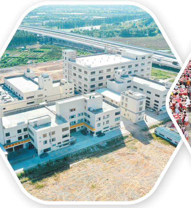
通过盘活闲置用地，威东村建起大草围工业区。
