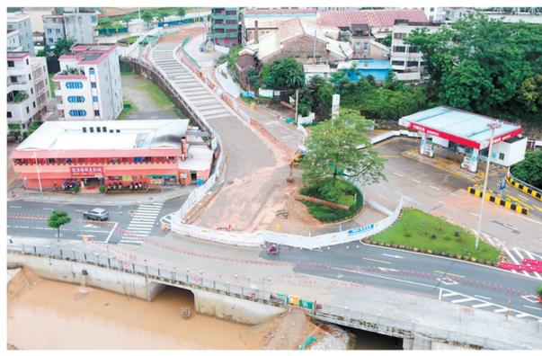
分洪暗涵已完成主体工程建设，正在进行基坑及路基土方回填。
