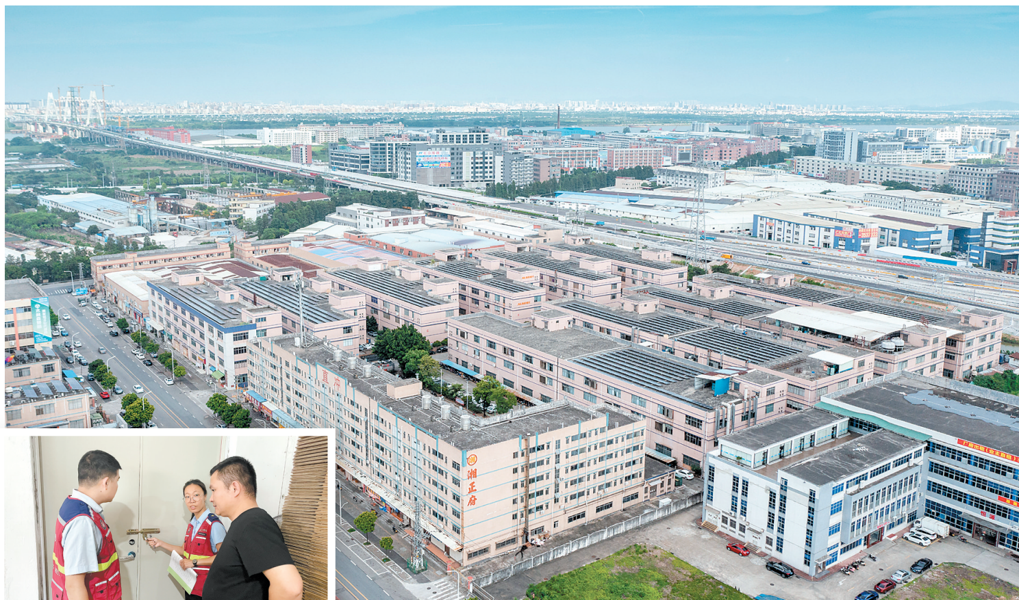
←陈燕婷和网格员正在开展安全生产检查。
