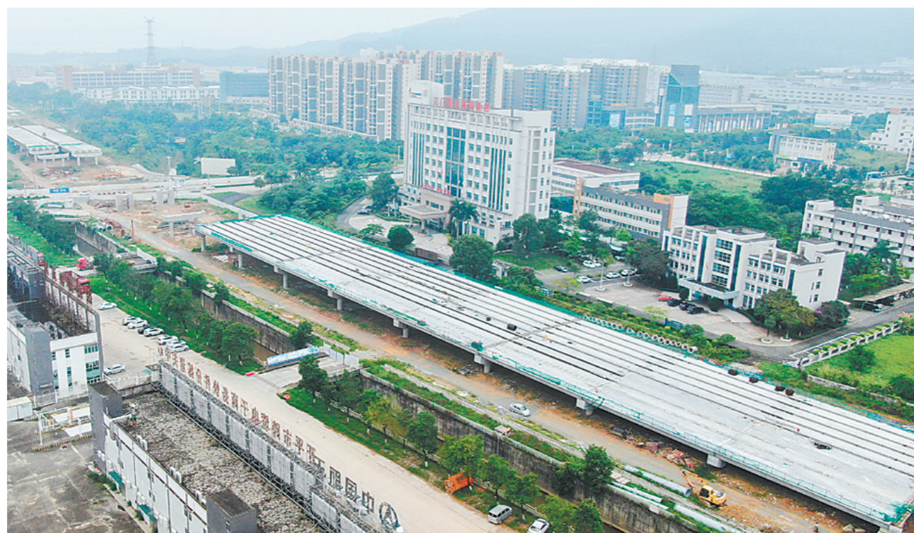
翠山湖互通主线桥已完成盖梁37个,完成预制梁安装155片,剩余现浇梁部分计划7月进入施工阶段。
