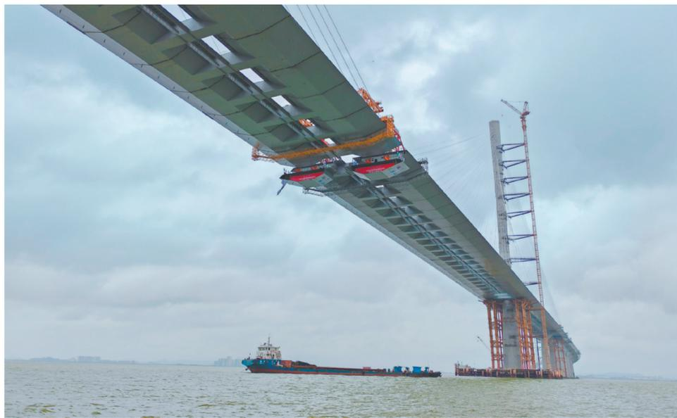
黄茅海大桥合龙后,黄茅海跨海通道整个项目的桥梁部分将全部合龙。图为合龙施工现场进行钢箱梁吊装。
