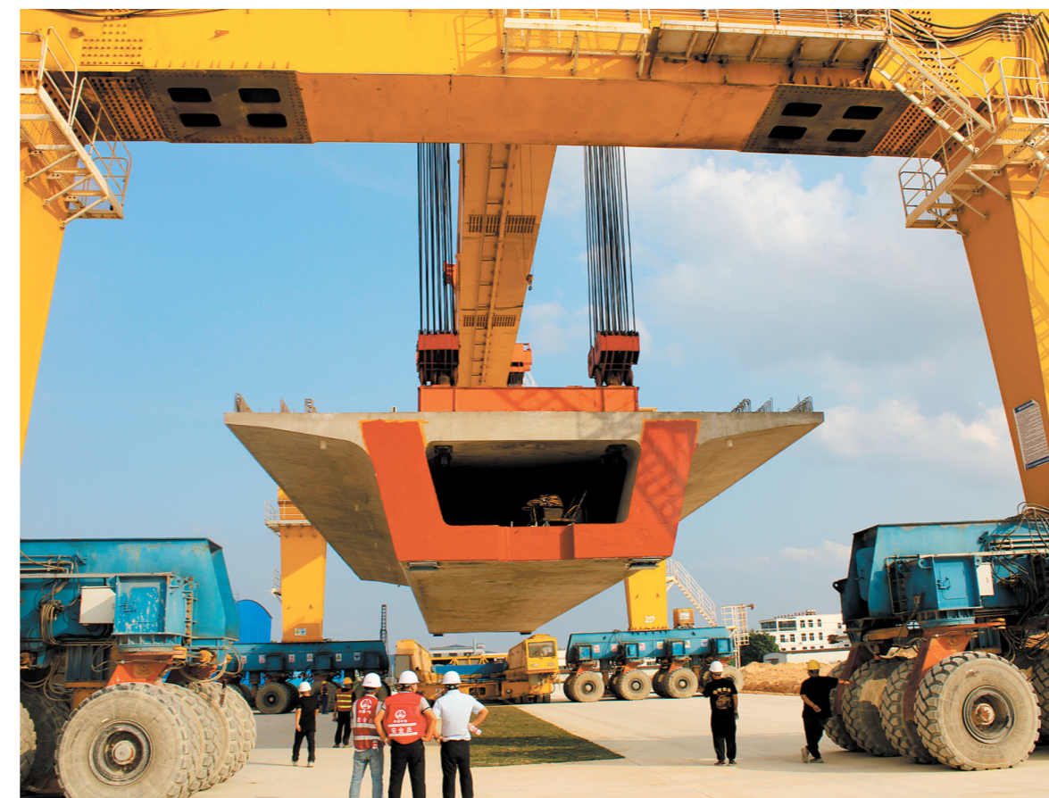
为加快融入“轨道上的大湾区”,鹤山市全力推动珠肇高铁鹤山段建设。图为今年3月27日,珠肇高铁全线首榀箱梁在鹤山顺利完成架梁,标志着项目正式进入箱梁架梁施工阶段。
