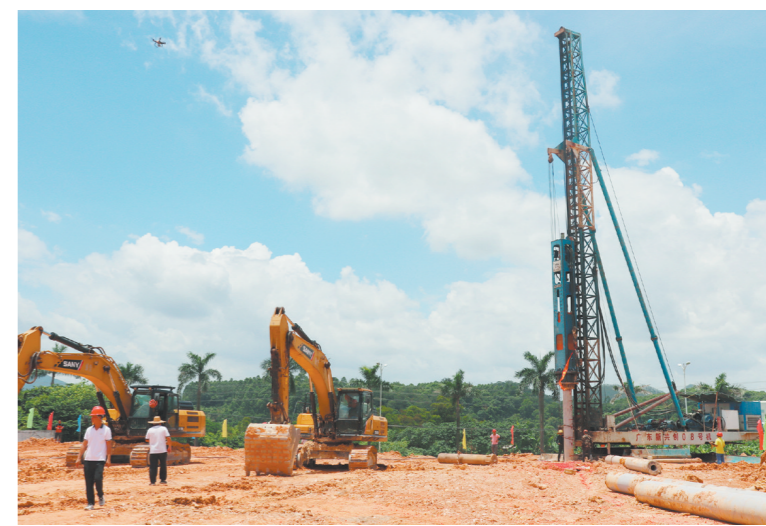
项目动工现场。
