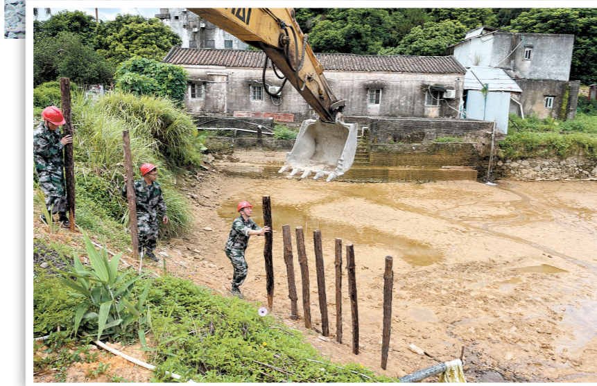
▲堤坝发生管涌“险情”,参训人员迅速装好沙袋、石子,做好堵住管涌口子的准备。
