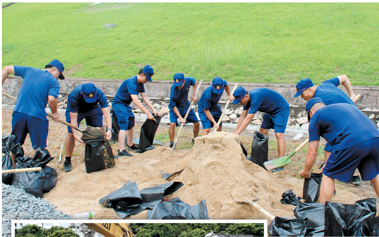
▲堤坝发生管涌“险情”,参训人员迅速装好沙袋、石子,做好堵住管涌口子的准备。
