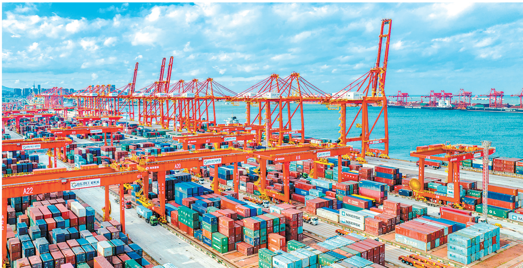
2024年7月2日拍摄的山东港口日照港集装箱码头(无人机照片)。新华社发
