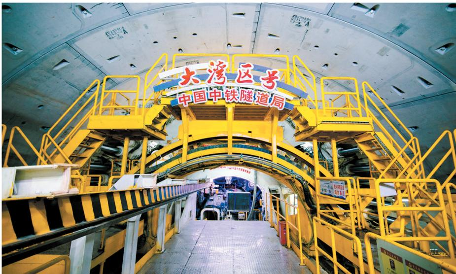
超大直径盾构机“大湾区号”率先完成了全部1468环的掘进任务。
