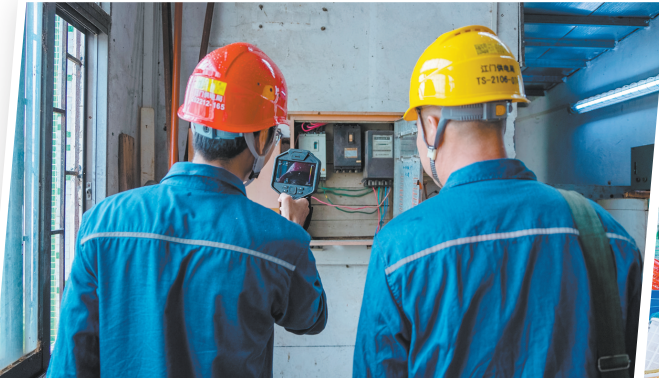
开渔前,江门台山供电局组织人员开展红外测温 and 负荷监测,及时消除缺陷和隐患。
