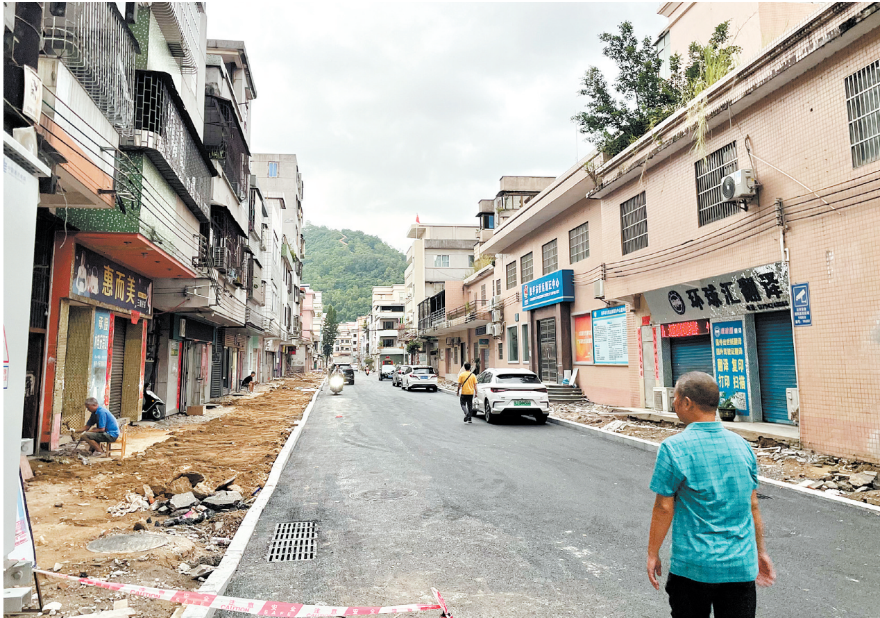
在人大代表的监督下,恩平城区根塘街等街道污水管道及内涝整治工程建设加快推进,即将完工通车。
