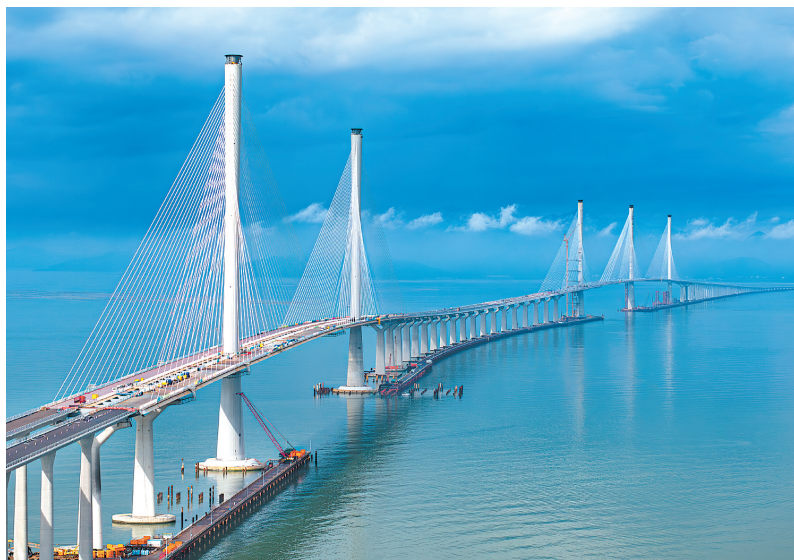
施工人员抢抓晴好天气,加快推进黄茅海跨海通道各项施工作业。
