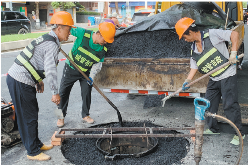
市政人员正在更换井盖。
