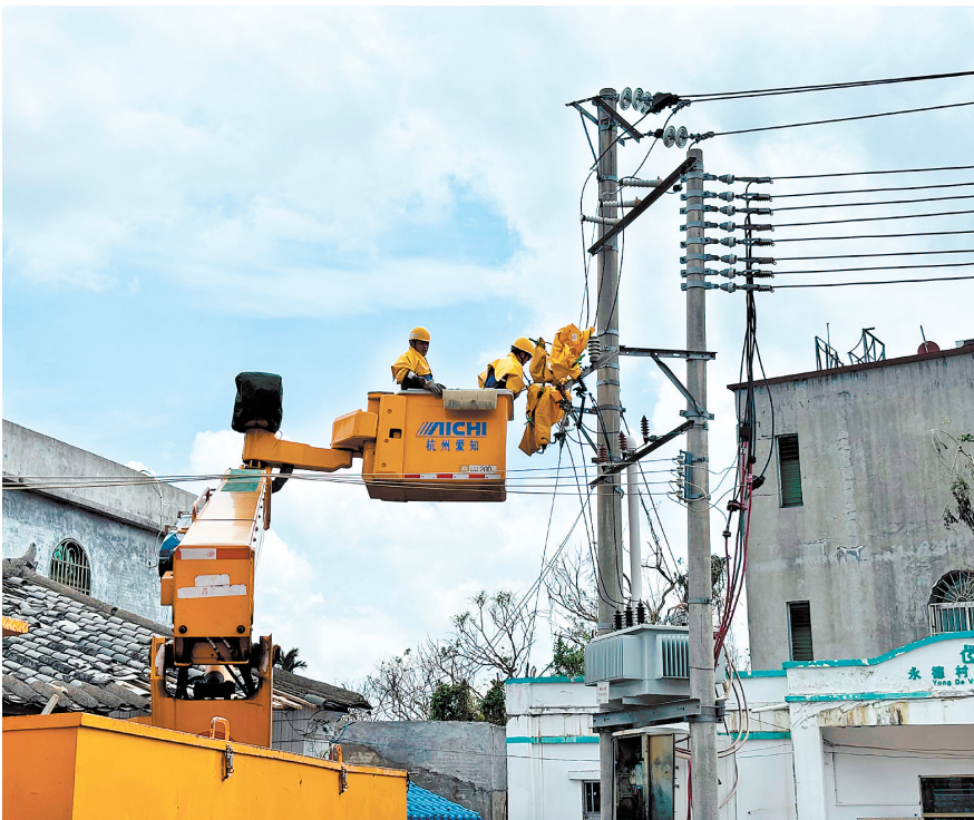
9月17日,江门供电局支援抢修复电队伍在海口市永兴镇开展抢修复电工作。
