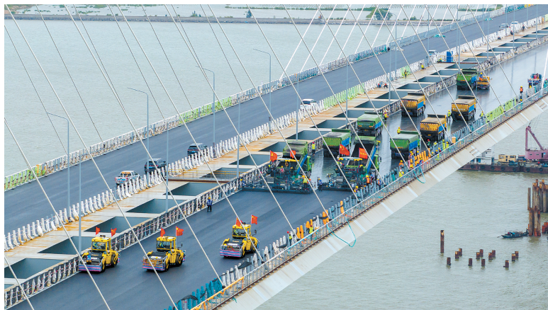
黄茅海跨海通道项目已顺利完成高栏港大桥双幅钢桥面铺装施工。图为施工现场。
