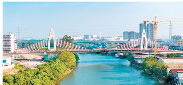
礼乐河大桥主桥中跨顺利合龙，即将进入桥面系及附属工程施工阶段。
