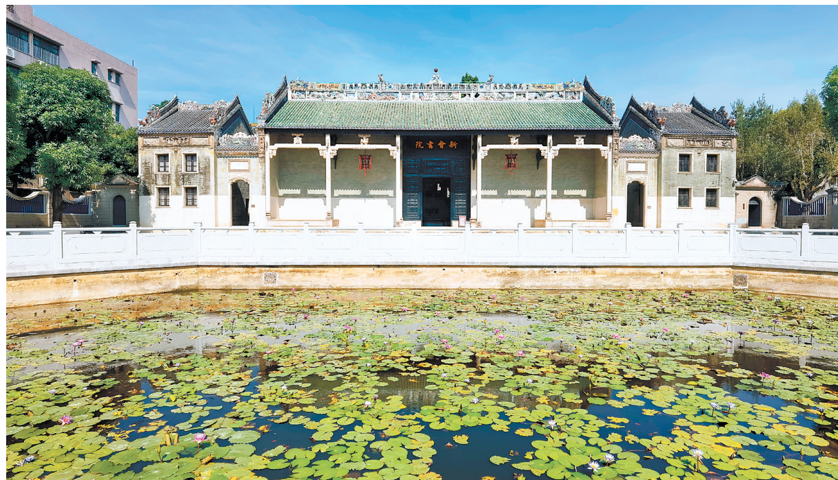
新会书院及周边环境硬件改造提升工程已完工。
