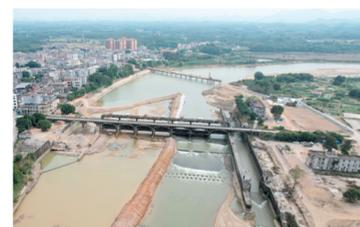
东成水闸重建工程已完成临时钢栈桥建设。
