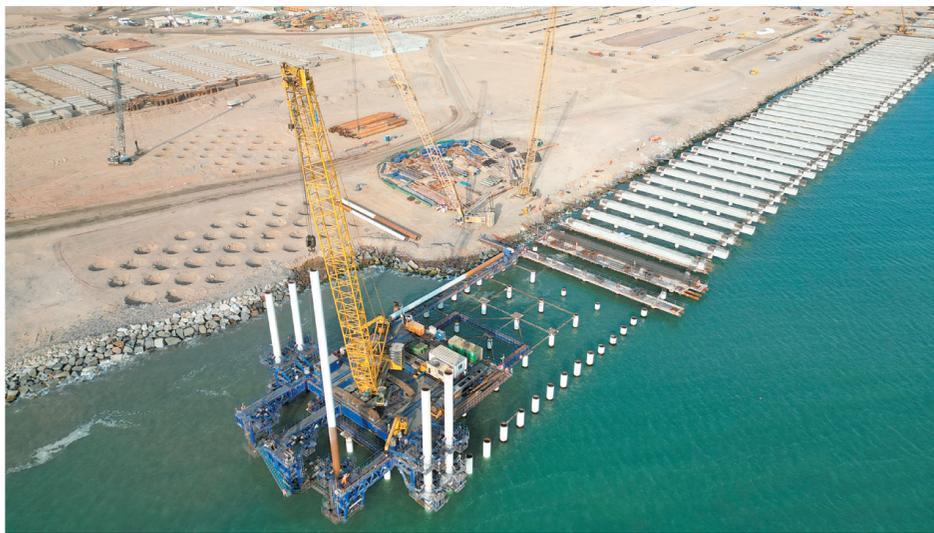
江门航通与兄弟公司联合研发的超大型自移动式打桩平台。通讯员供图
