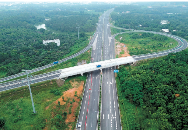
公用集团党委全力打造“先锋工地”，国道G240项目工程队的党员发挥先锋模范作用，严抓进度、质量、安全。
