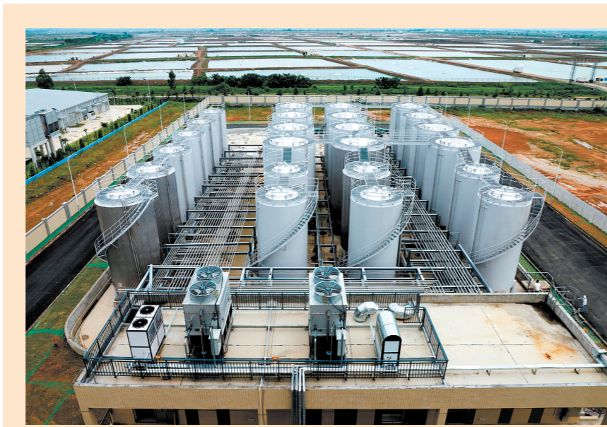
广东合兴食用油脂有限公司将新厂建在了斗山镇。
