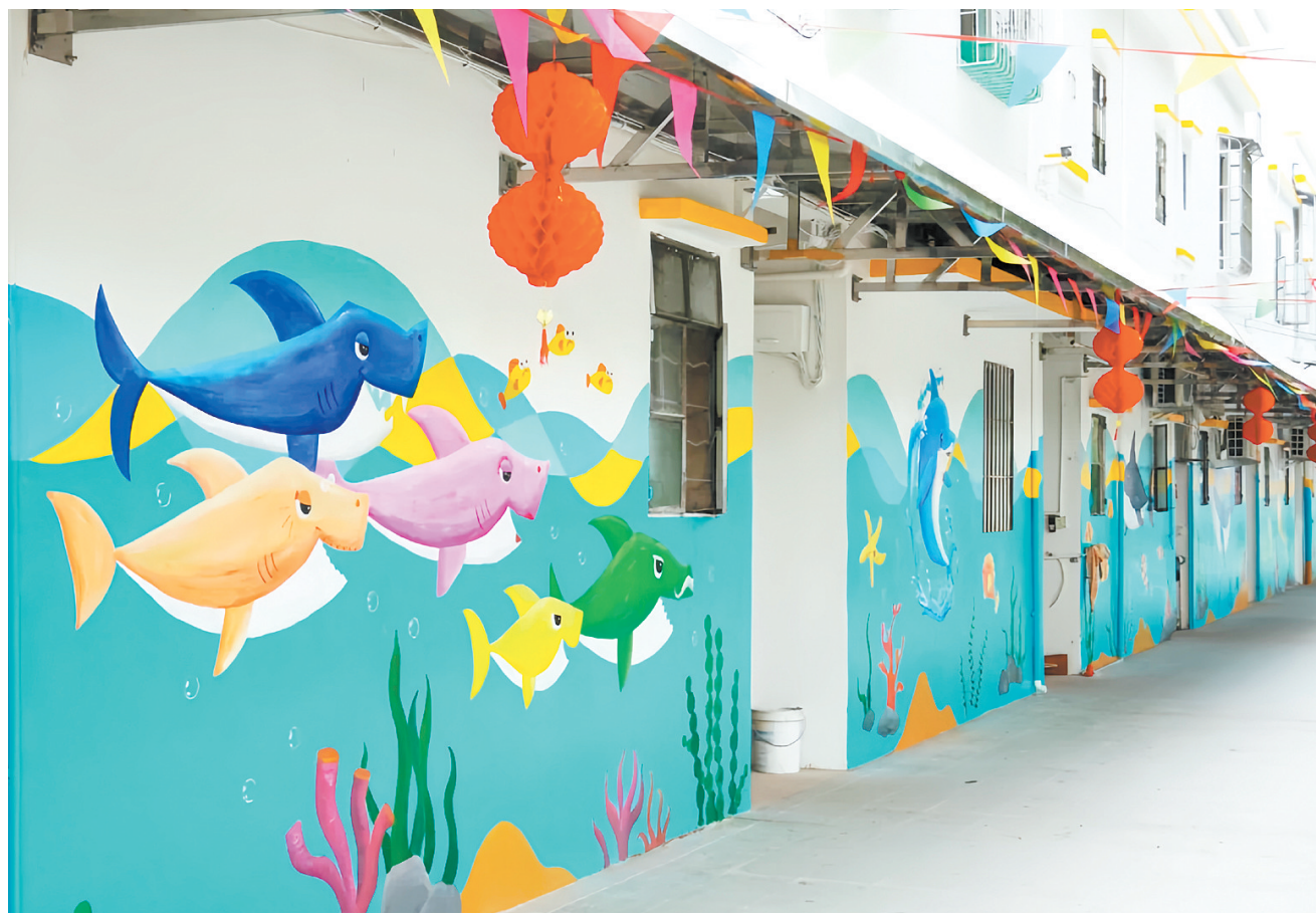
改造后草洲村小区，楼栋外立面整洁干净，让人眼前一亮。
