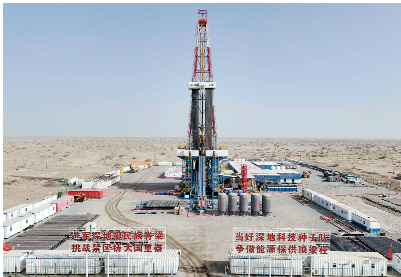
2月19日在新疆塔克拉玛干沙漠腹地拍摄的中国石油塔里木油田深地塔科1井(无人机照片)。新华社发
