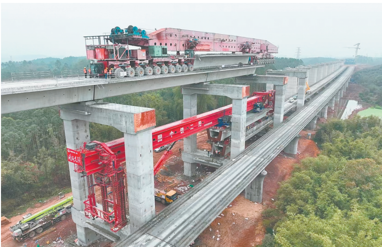
施工人员进行箱梁架设工作。
