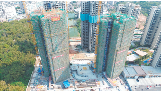
江发中交·悦山湖B8号楼顺利完成主体结构封顶。
