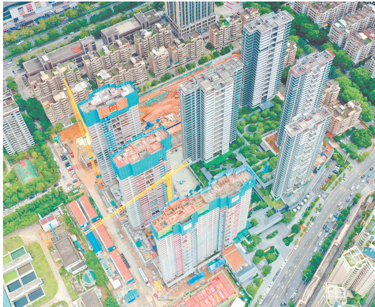
江门保利琅悦项目二标段共4栋高层住宅主体结构封顶。
