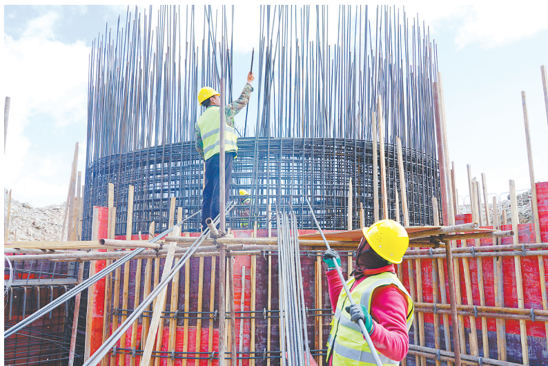
6月21日,施工人员在青海冷湖天文观测研究基地的望远镜项目施工现场作业。 新华社发
