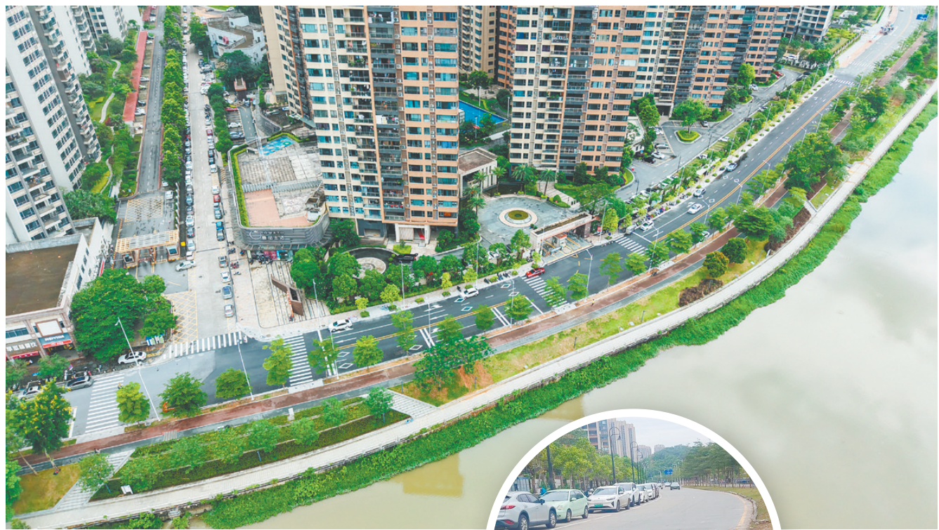
↑实施改造工程后，桂香路变为双向两车道，并铺上沥青罩面，让车辆通行更加顺畅。
